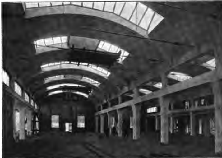
Abb. 70. Gießhalle von Siemens u. Halske, Nonnendamm-Berlin.
